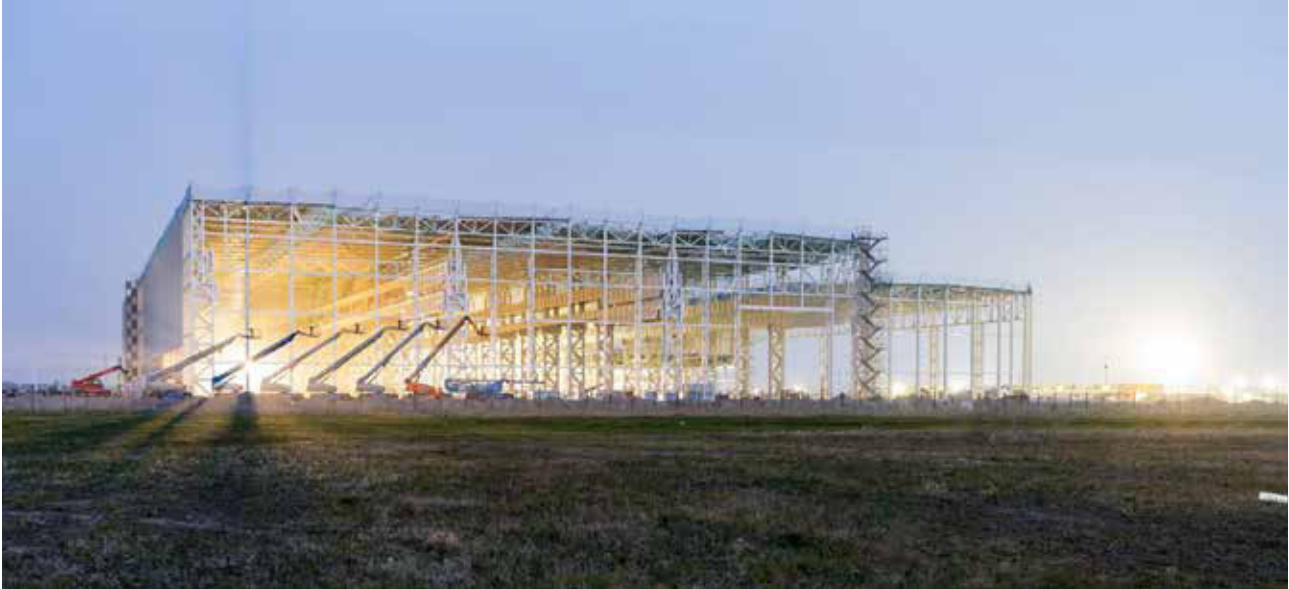
Siemens Cuxhaven: In nur 10 Monaten sollten Produktionshalle samt Nebengebäude fertig gestellt sein.
