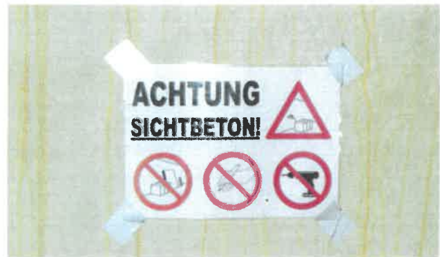
Bild 1. Schutz der Leistung „Sichtbeton“ durch Anbringen von Hinweisschildern
