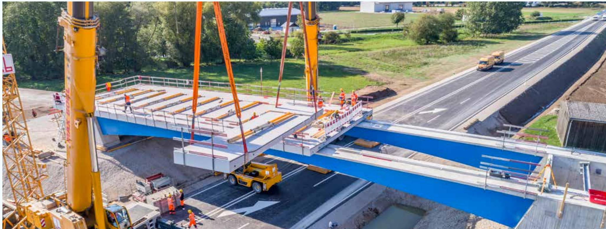
Mit Fertigbauteilen lassen Brücken sich weit rascher bauen als mit hergebrachten Methoden. Nur bei sehr großen und hohen Brücken funktioniert dies noch nicht
