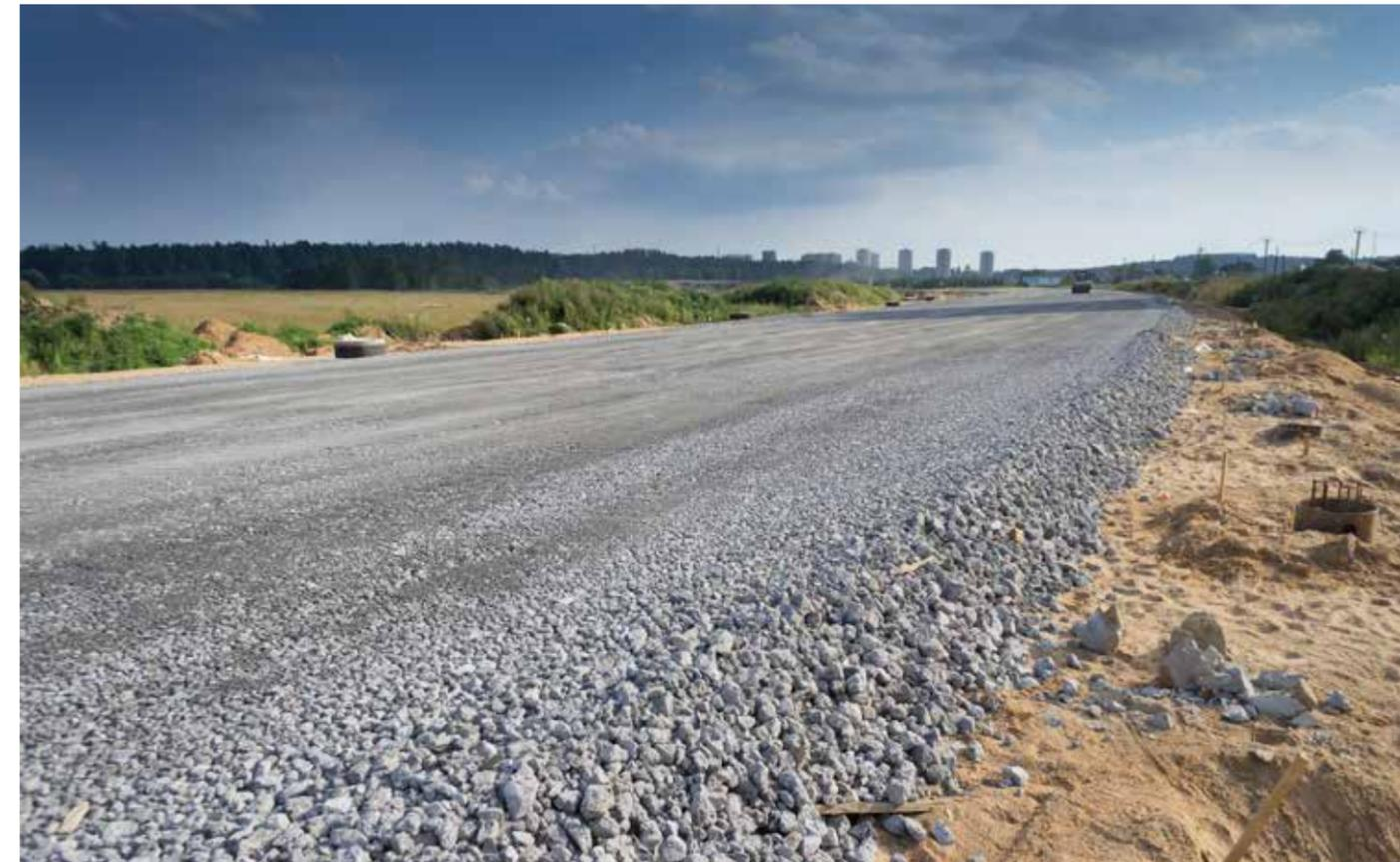
Recycling-Schotter im Straßenbau. Hier eignet sich Betonaufbruch besonders als Frostschuttschicht im Unterbau
