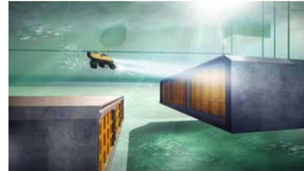
Die Tunnelelemente werden unter Wasser zusammengefügt, nachdem sie aus dem Arbeitshafen herangeschleppt wurden
