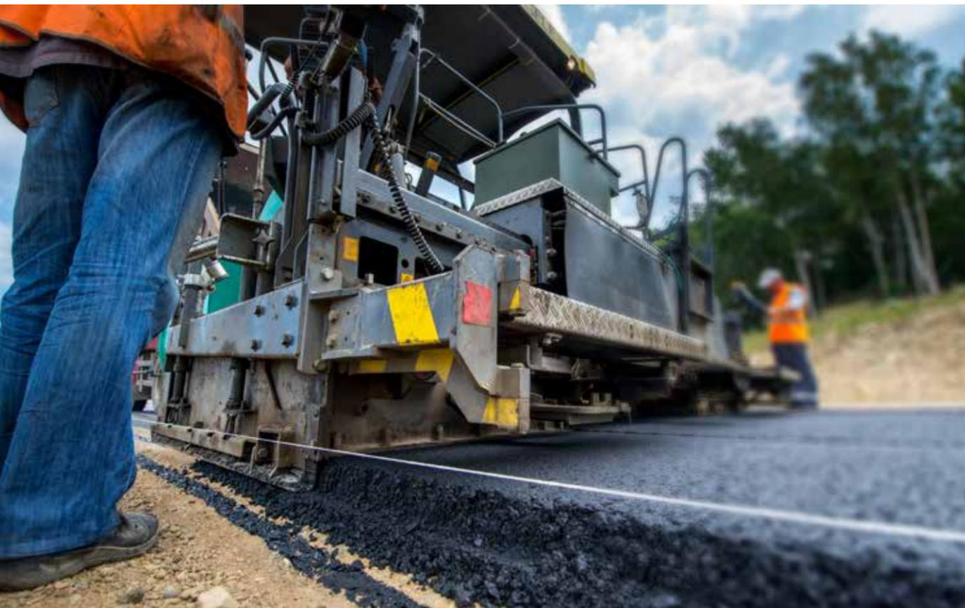
Teermaschine war früher, Schwarzdeckenfertiger heißt das Baugerät heute, mit dessen Hilfe die wunderbar plane Asphaltdecke auf Straßen entsteht
