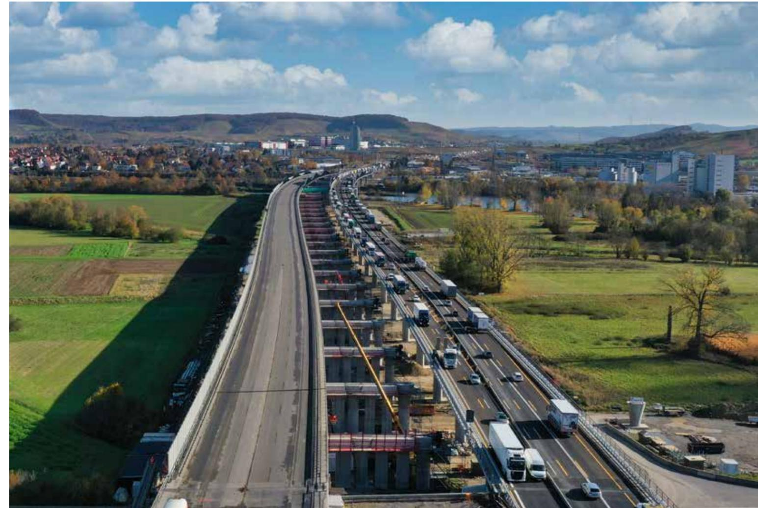
Noch liegt die neue Trasse links neben der Spur. Aber während auf der rechten Seite der Verkehr rollt, wird die neue Fahrbahn Millimeter für Millimeter an ihr Gegenstück herangezogen
