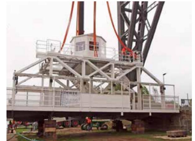
Bevor die Fahrfläche in den Fahrwagen eingehängt wird, muss sie auf Holzstapeln exakt auf Höhe und Lage gebracht werden
