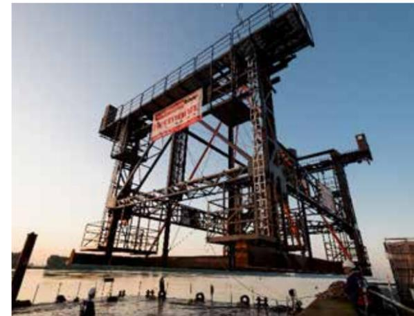
Mit vormontiertem Fahrwagen wird die Schwebbahnneinheit auf einen Ponton verladen
