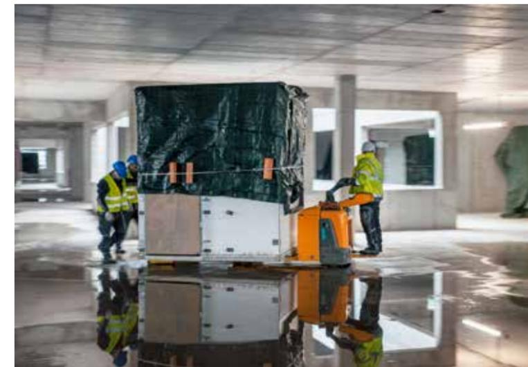
Serielle Gestaltungsmöglichkeiten, Schnelligkeit beim Badeinbau und dünne, aber dennoch stabile Wandelemente aus Beton gehören zu den Vorzügen der Fertigbäder von Kerapid
