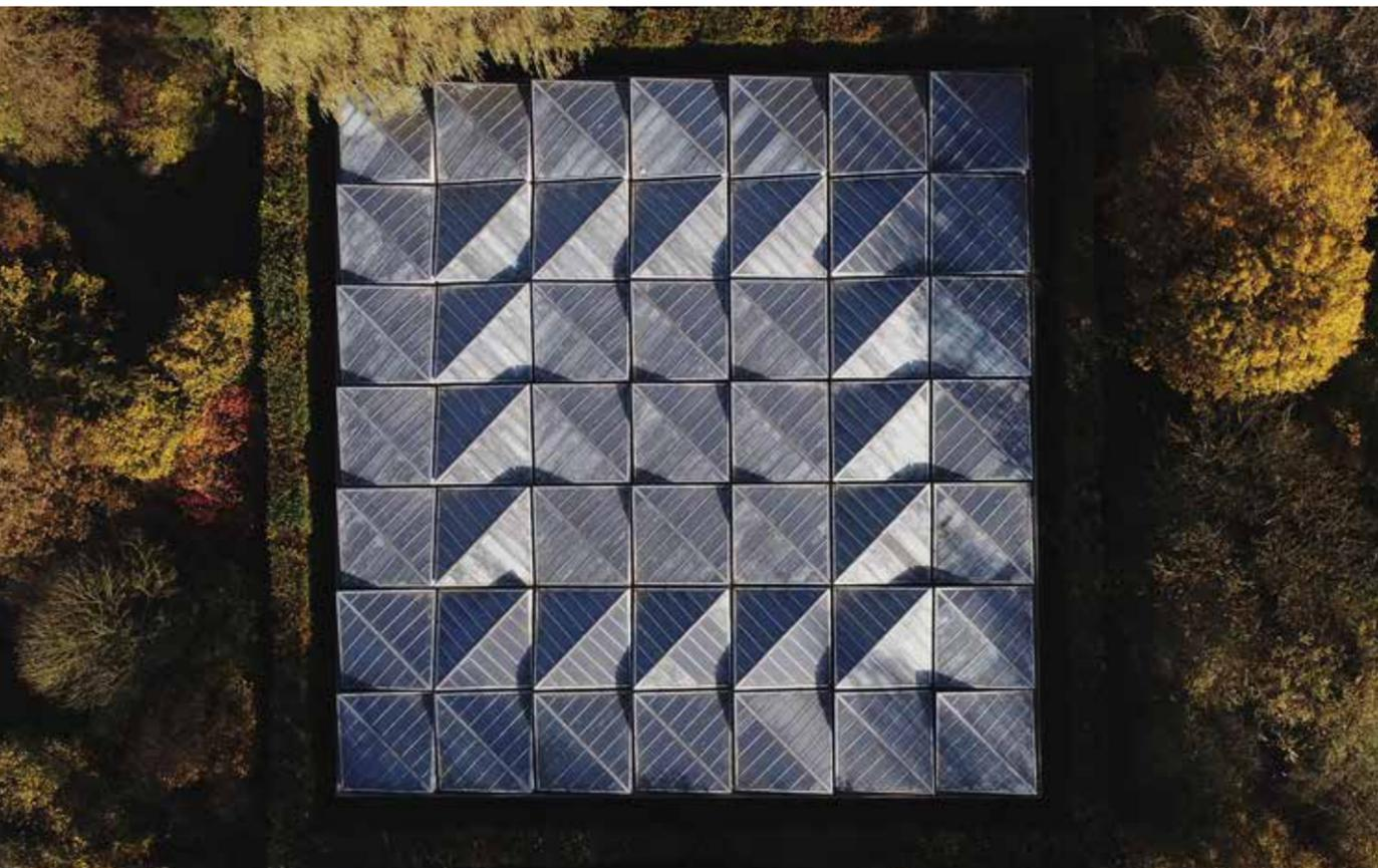
Die Glasdachkonstruktion des »Labyrinths« besteht aus 49 Einzeldächern in Prismenform
