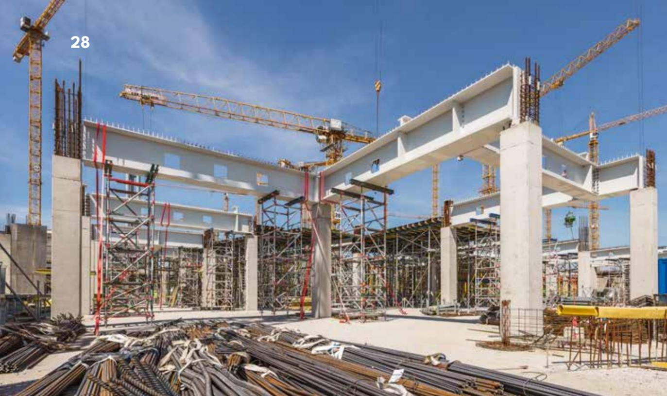
Weitgespannte Träger über dem Mall-Bereich sowie komplexe, sehr hoch belastete Trägerroste im Bereich des Kreuzfahrtterminals
