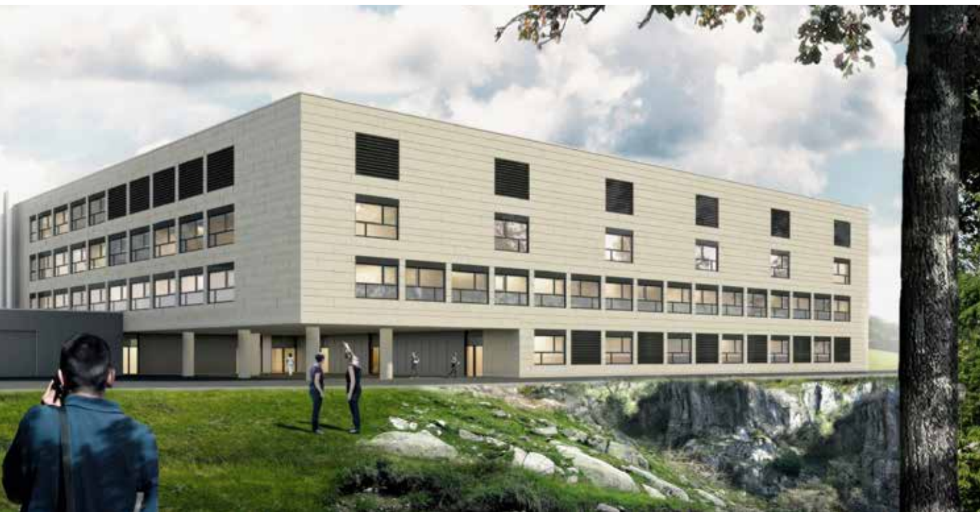
Das Klinikum Bayreuth: Der erste Bauabschnitt umfasst die Errichtung der zentralen OP-Abteilung samt Labor- und Bereitschaftsräumen sowie der Ver- und Entsorgungslogistik und der Energiezentralen
