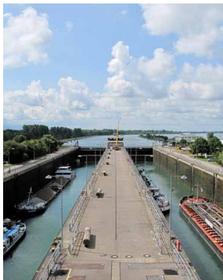
Schleuse Iffezheim: Blick auf das Oberwasser
