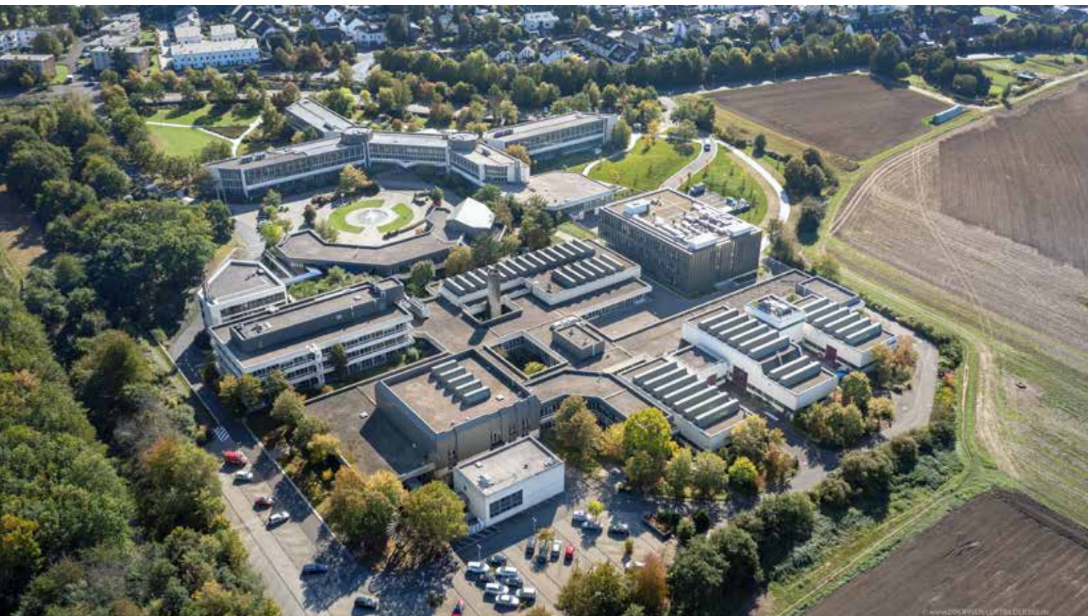
Der weitläufige Campus der DGUV in Sankt Augustin zeigt, wie herausfordernd es ist, die Baustelle so zu organisieren, dass der Arbeitsbetrieb ungestört weiterlaufen kann
