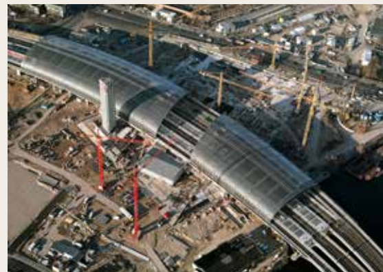
Der Berliner Hauptbahnhof im Bau, hier noch ohne die beiden Bürohochhäuser über dem Glasdach
