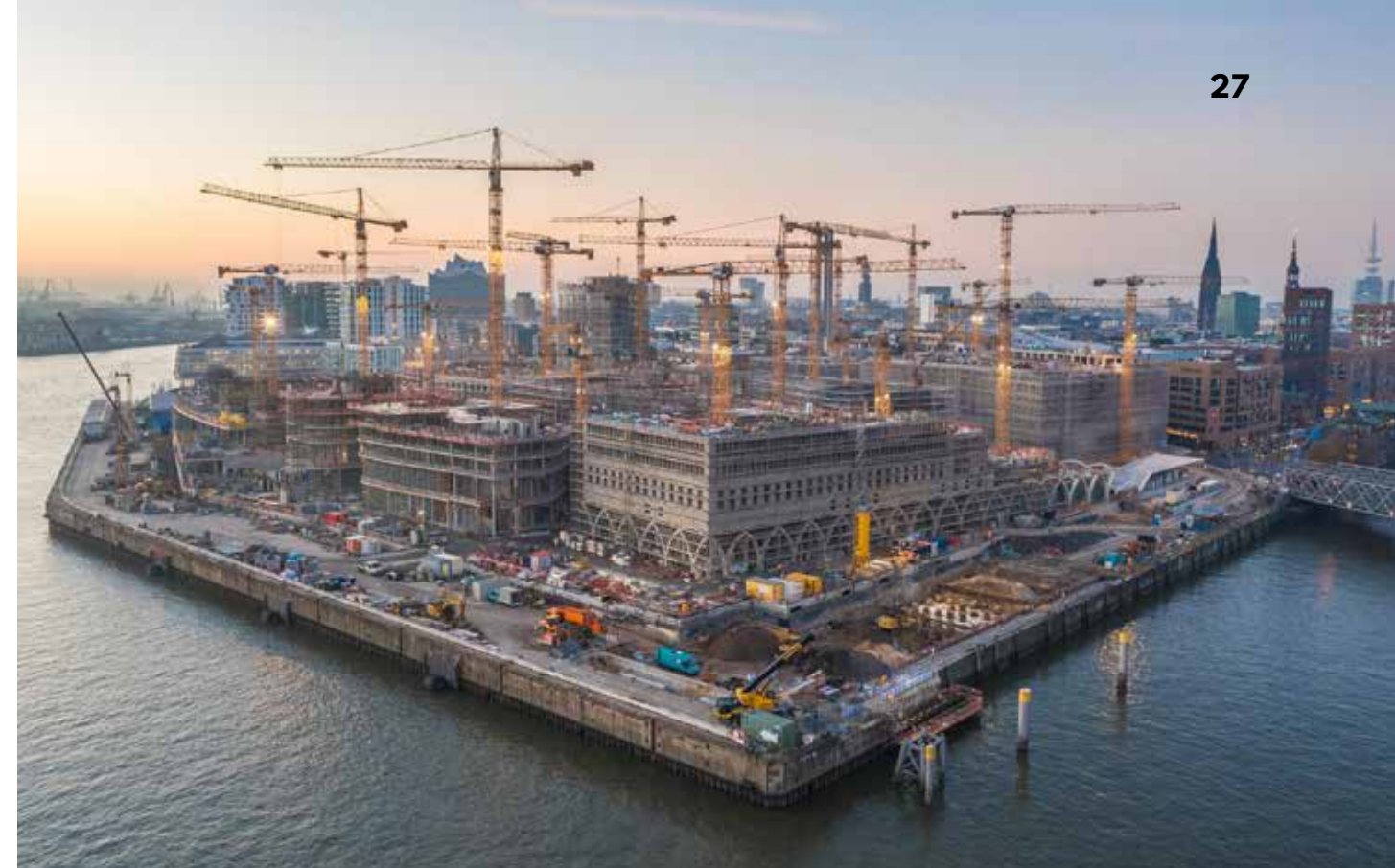
Blick auf die größte Baustelle Hamburgs: Das südliche Überseequartier nimmt Gestalt an
