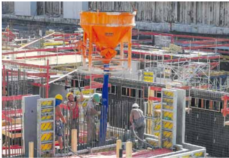
Baubetriebe sind auf pünktliche Zahlungen angewiesen, um Material- und Lohnkosten zu begleichen.
