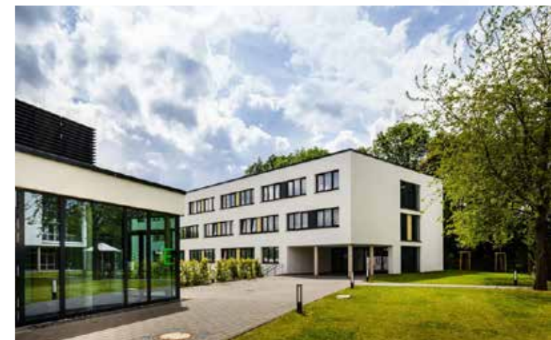
Neubau und Sanierung erfolgen im laufenden Betrieb der Hochschule
