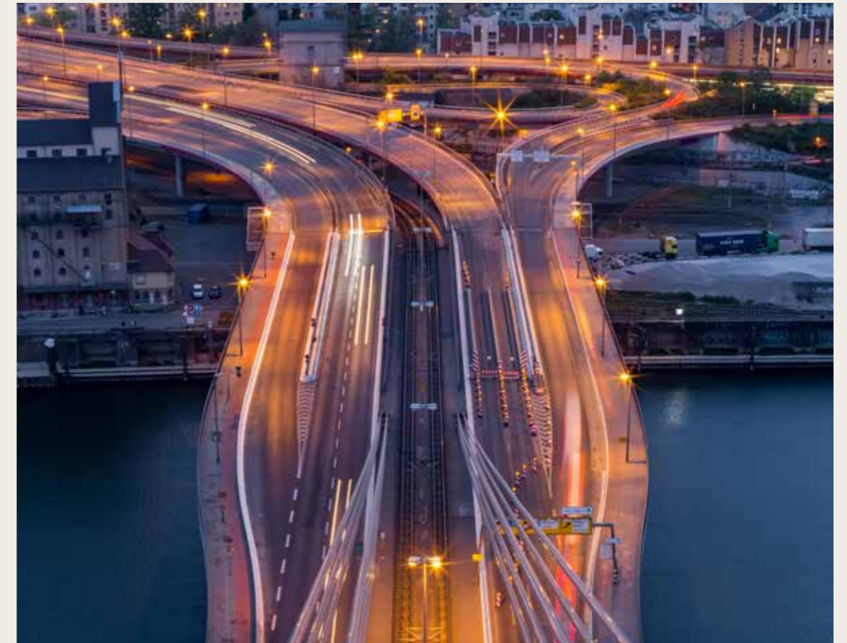
Die Hochstraße Nord in Ludwigshafen
