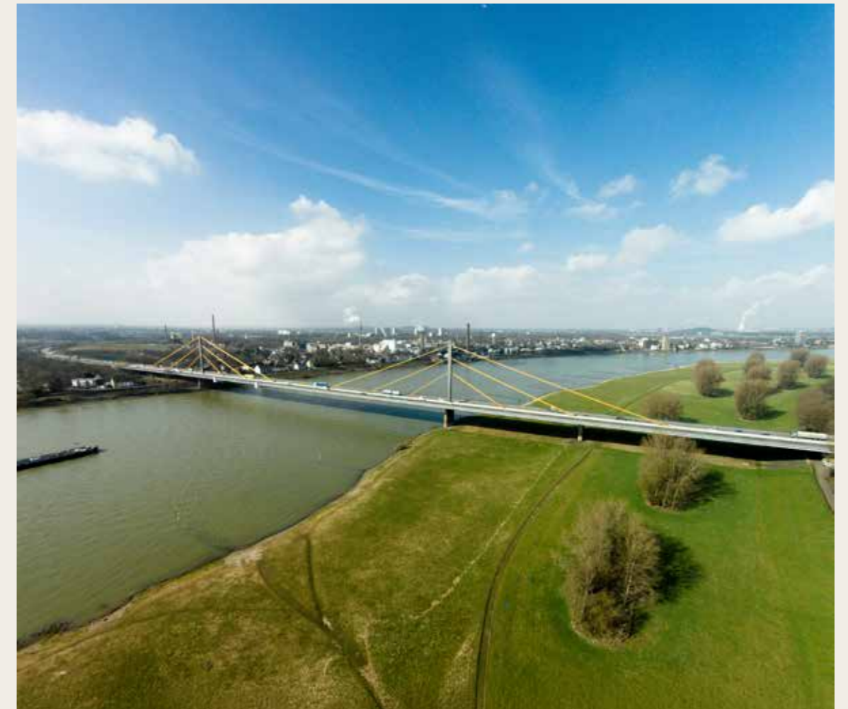
Die Rheinbrücke der A40 bei Duisburg-Neuenkamp
