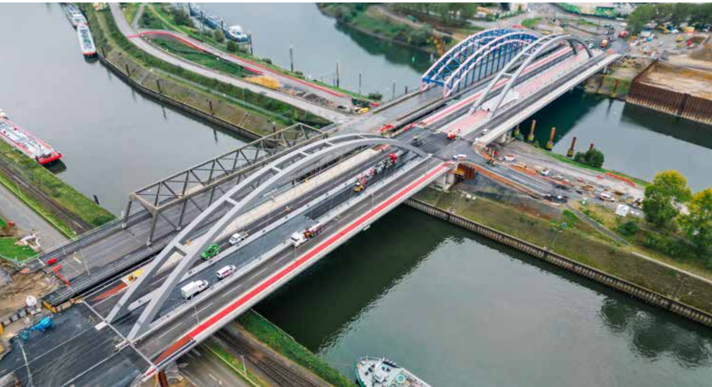
Aktuelle Bilder zeigen, dass das Bauvorhaben Form annimmt
