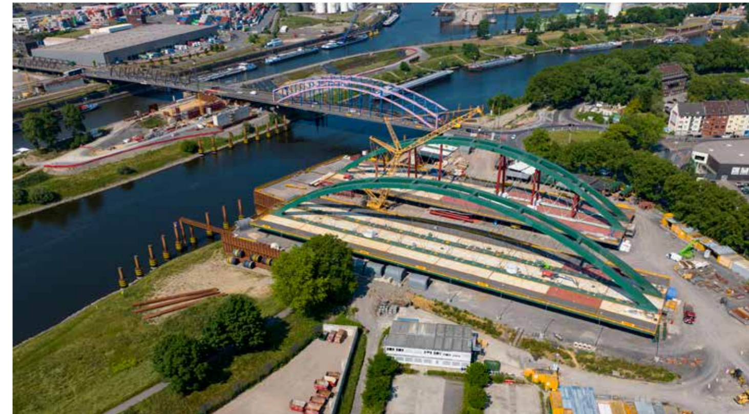
Bereit für die nächsten Bauphasen: die Brücken zu Beginn des Projekts auf dem Vormontageplatz
